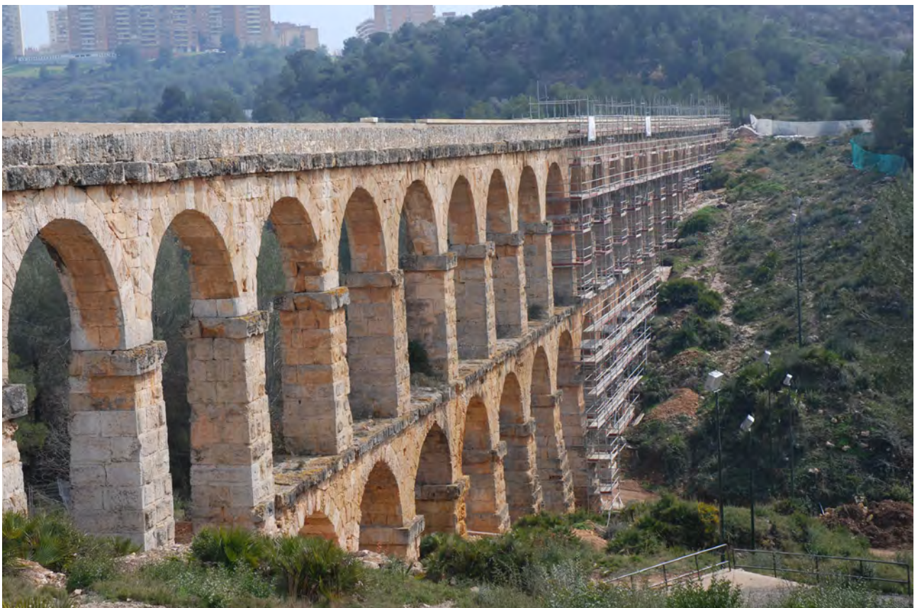
FIGURA 8. Aqüeducte del pont del Diable durant els treballs de restauració recents.
